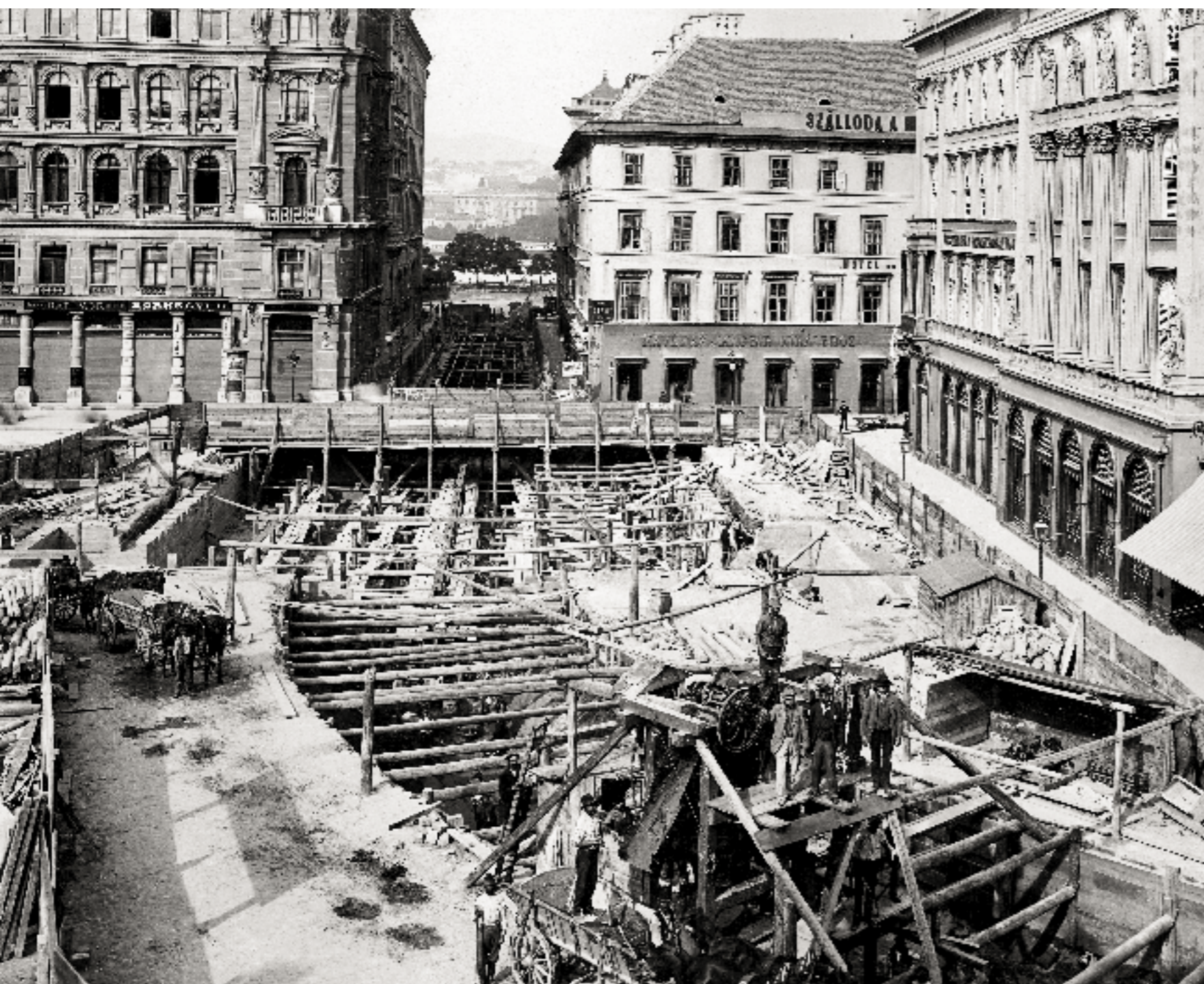
Construction site in Giselaplatz, 1895
