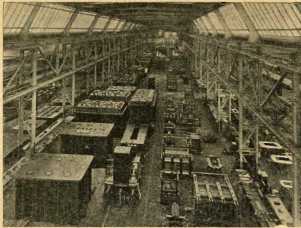
Ansicht der Groß-Montagehalle des Transformatorenwerkes. In der Mitte 110-t-Wagen des Bayernwerkes mit 16000-kVA-Transformator beladen
