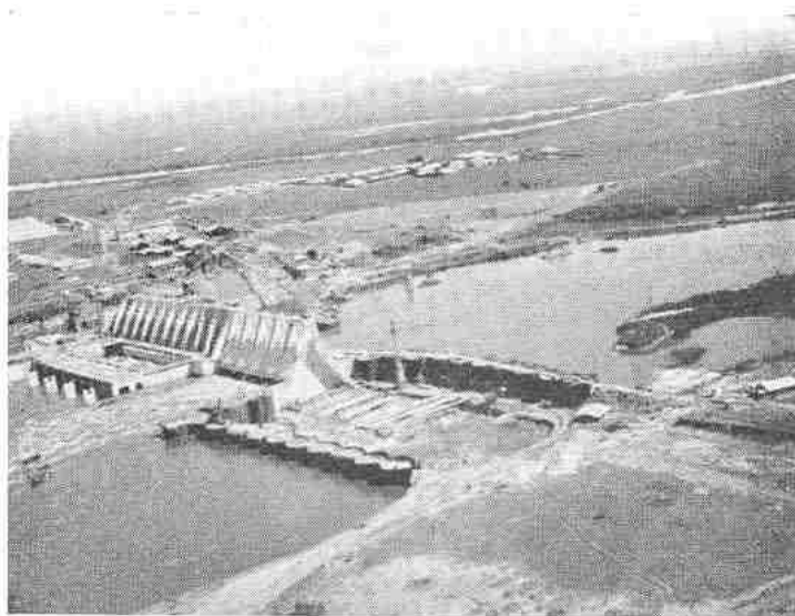
Rincón del Bonete: Zanja II. - Construcción de las bases de los pilares U3 y U7 y lecho amortiguador. - 10 de setiembre de 1940
