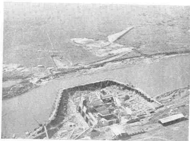
Rincón del Bonete: Zanja I y excavación en la margen izquierda. - 3 de agosto de 1939
