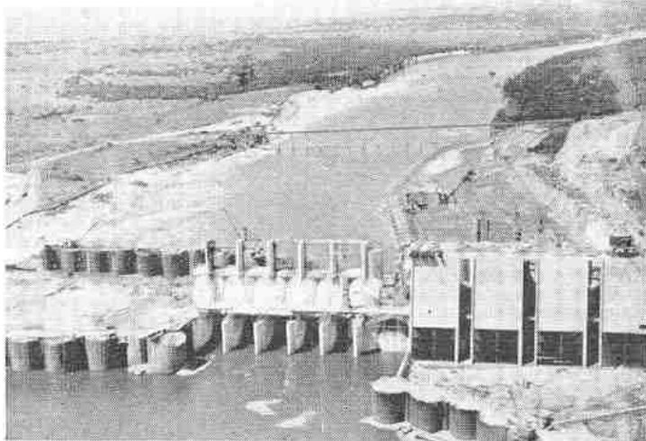
Rincón del Bonete: Dique visto desde aguas arriba. - Aberturas provisionarias en los pilares U8 a U13. - 11 de marzo de 1940
